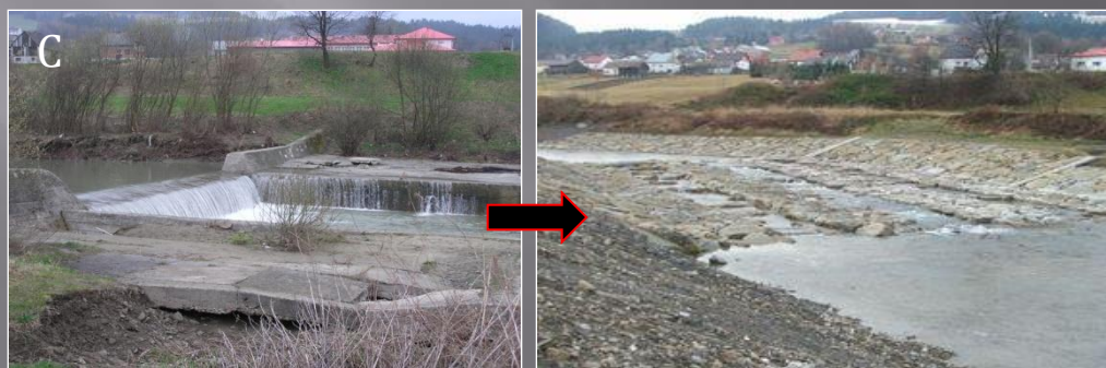
Ryc. 4. Bariery migracyjne w Pleśnej (A), Grybowie (B), Kąclowej (C), Ciężkowicach (D) przed i po modernizacji fot. M. Przebięda, M. Jelonek.
